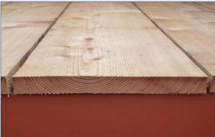
**Detail einer Außenschalung aus Lärchenholz, die durch richtige Ausrichtung und Befestigung der breiten Schalungsbretter das Quellen und Schwinden derselben zulässt.**
