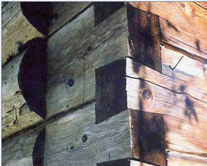
Sogenannter "Tiroler-Eckverband" eines Blockbaus, Hallstatt, erste Hälfte des 20. Jahrhunderts. Die Rundhölzer sind an den Auflagflächen zweiseitig, an den Enden vierseitig mit der Breithacke behauen. Der Eckverband hält formschlüssig ohne zusätzliche Verbindungsmittel in zwei Richtungen.
