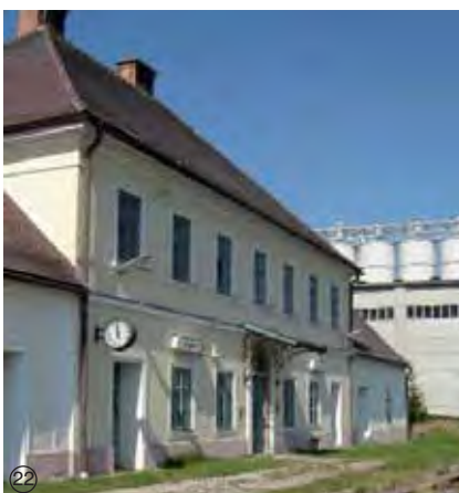
Das Stationsgebäude von Engelhof / Gmunden, 1835 erbaut, ist heute das älteste noch immer dem regulären Eisenbahnbetrieb dienende Bahnhofsgebäude Europas. Das Photo lässt noch die beiden flankierenden Stallgebäude wie zur Zeit der Pferdeisenbahn und des Schmalspur-Dampfbetriebes erkennen (Photo: © Spitzbart).
