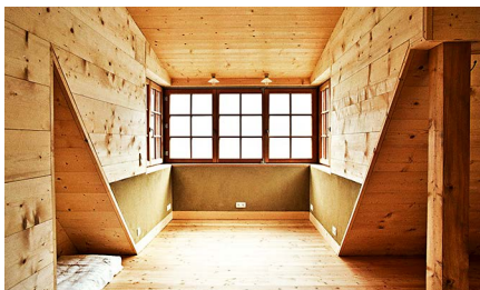
▲ Wohnhaus Hallstatt, Wohnraum Fachwerkskonstruktion mit Massivholzausfachungen und querliegenden Wandbohlen. Die Wandheizung ist im Lehmputz des Parapetbereichs integriert (Parapet = Wandbereich unterhalb der Fenster)
