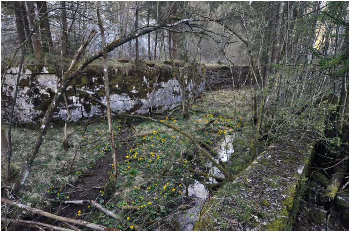
Abbildung 5, Rechenanlage Gosaumühle, Quadergemauerter Kanal, Zustand 2014, Foto Idam
