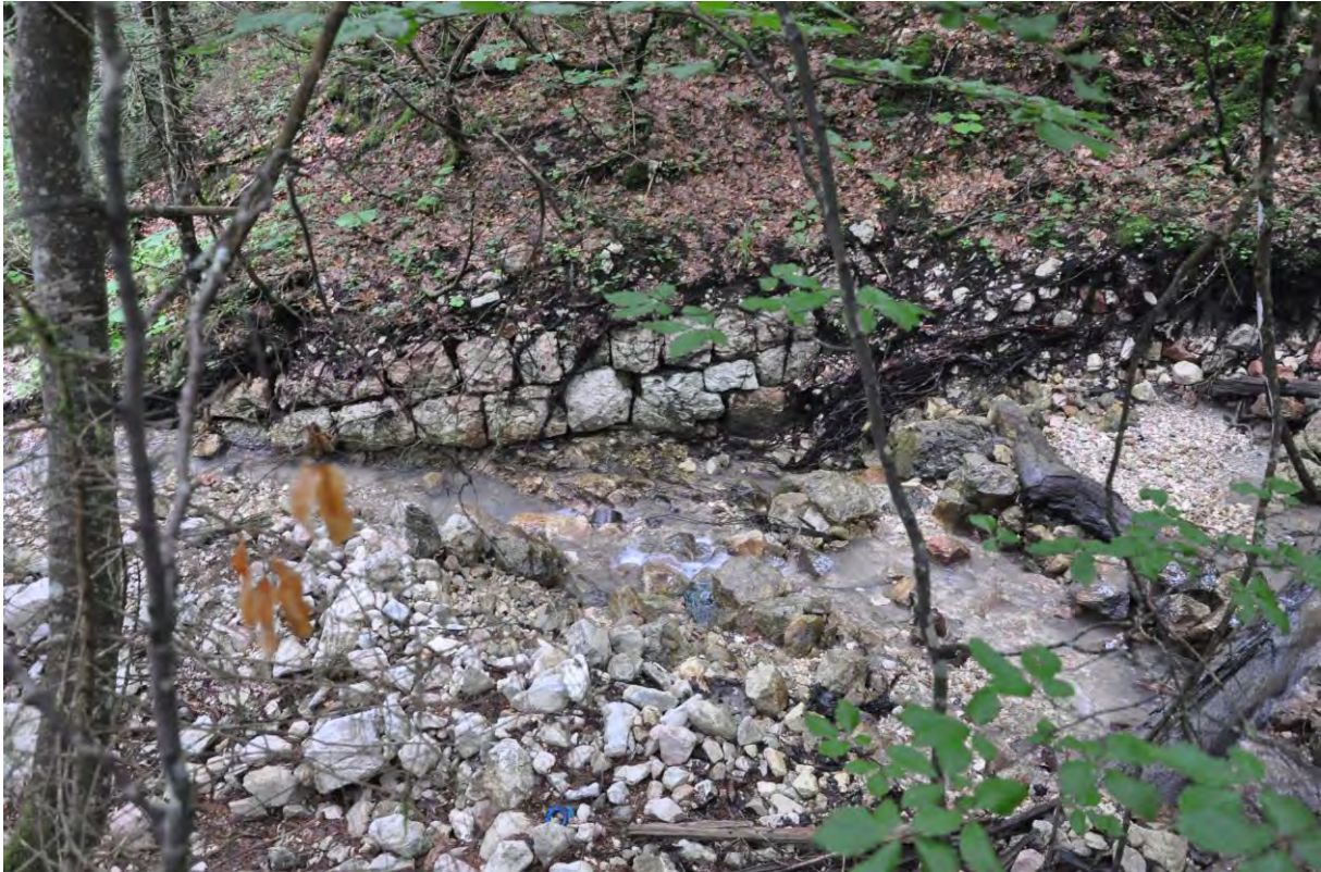
Steinbergbachverbauung, Rest einer Längsverbauung, Quadermauerwerk, 1078m N47°33,925' E13°37,717', Aufnahme Idam 2014
