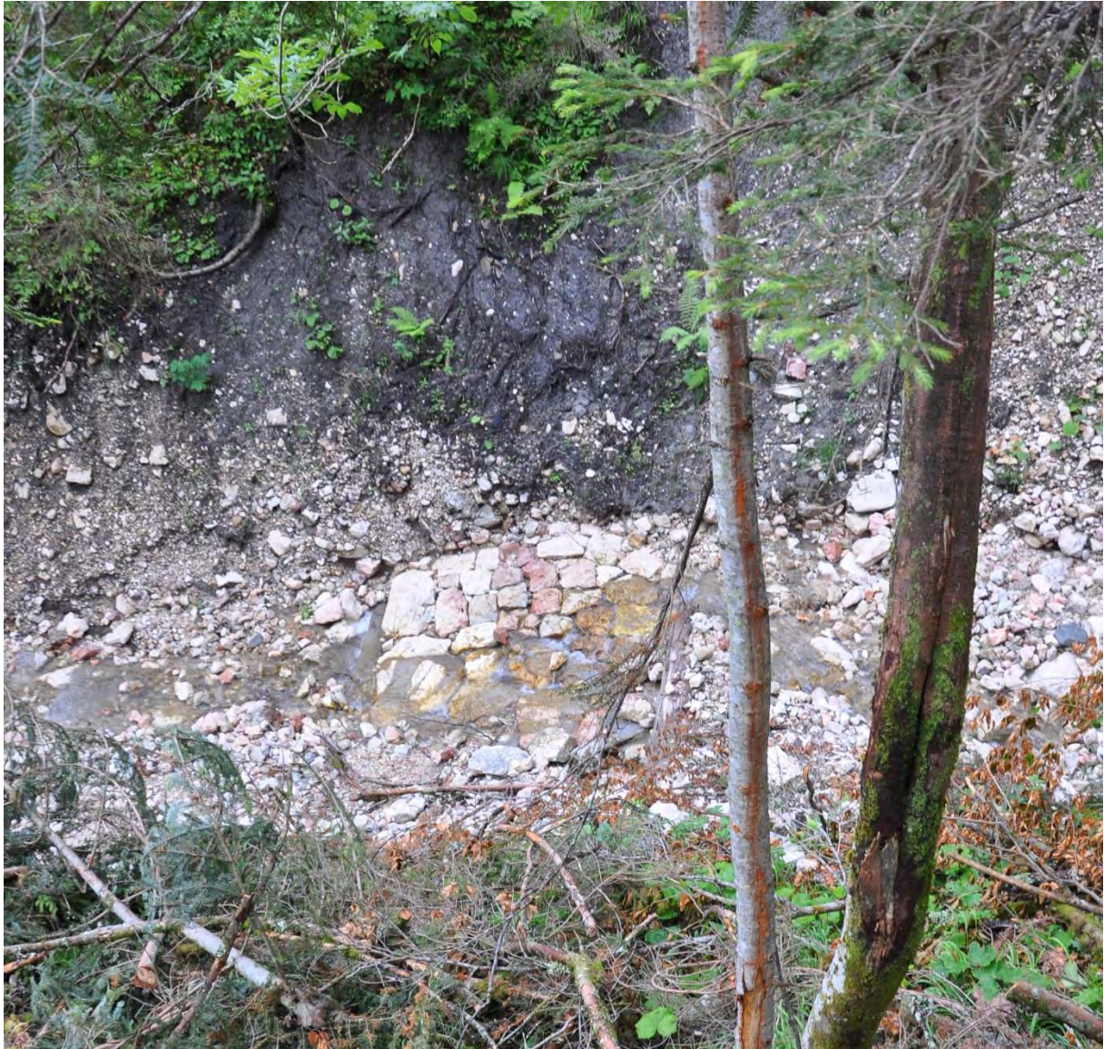
Steinbergbachverbauung, Erhaltenes Sturzbett aus Quadermauerwerk, 1056m N47°33,898' E13°37,768', Aufnahme Idam 2014
