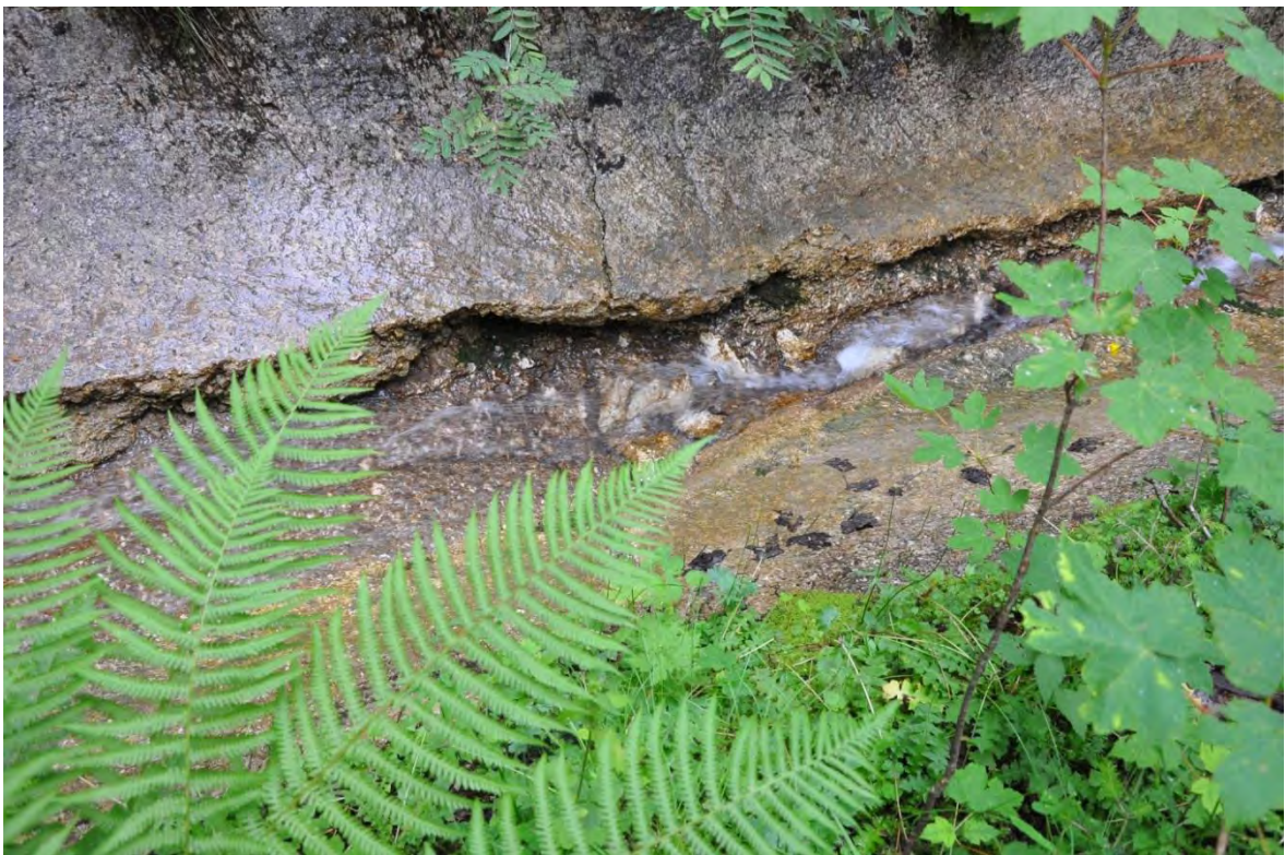
Abbildung 55, Beton versus Quadermauerwerk, Steinbergbachverbauung, Detail, Salzberghochtal, 1056m N47°33,898' E13°37,768'
