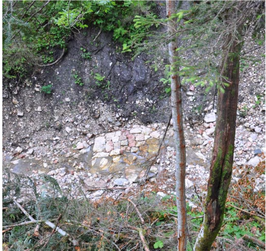
Abbildung 45: Steinbergbachverbauung, Erhaltenes Sturzbett aus Quadermauerwerk, 1056m N47°33,898' E13°37,768', Aufnahme Idam 2014
