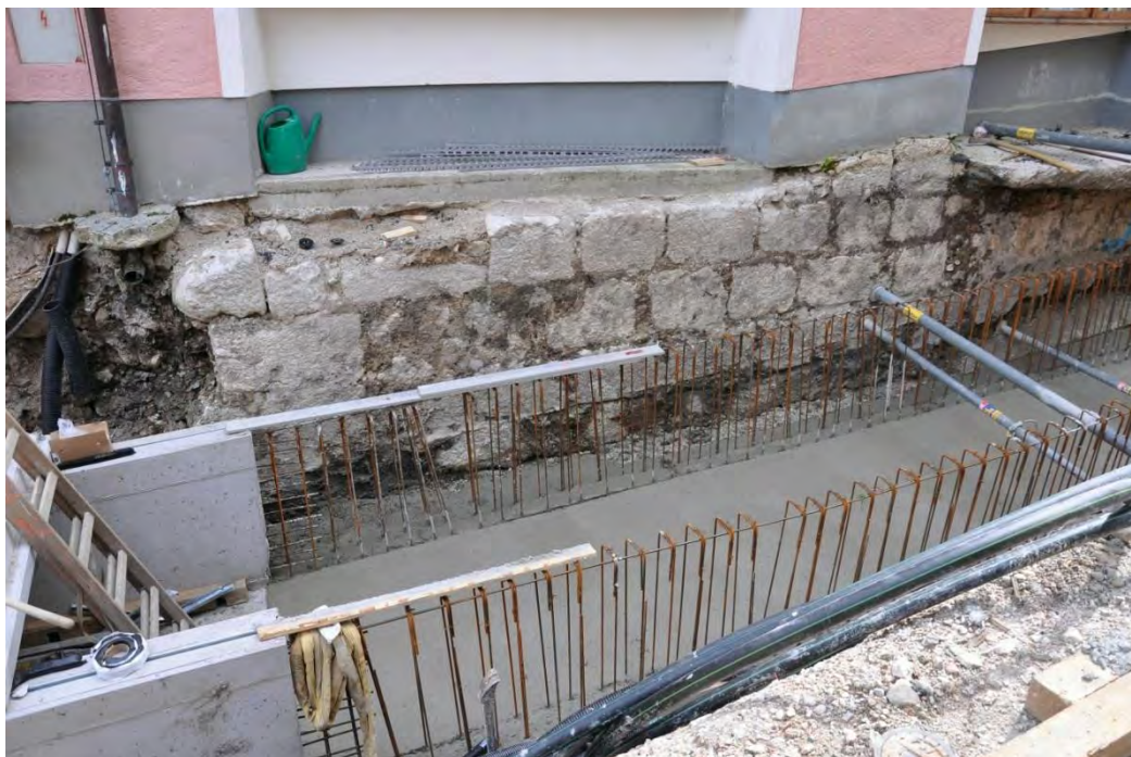
Abbildung 40, Einbau eines Betonkanals in den wiedergeöffneten Steinkanal, Aufnahme Idam 2015.
