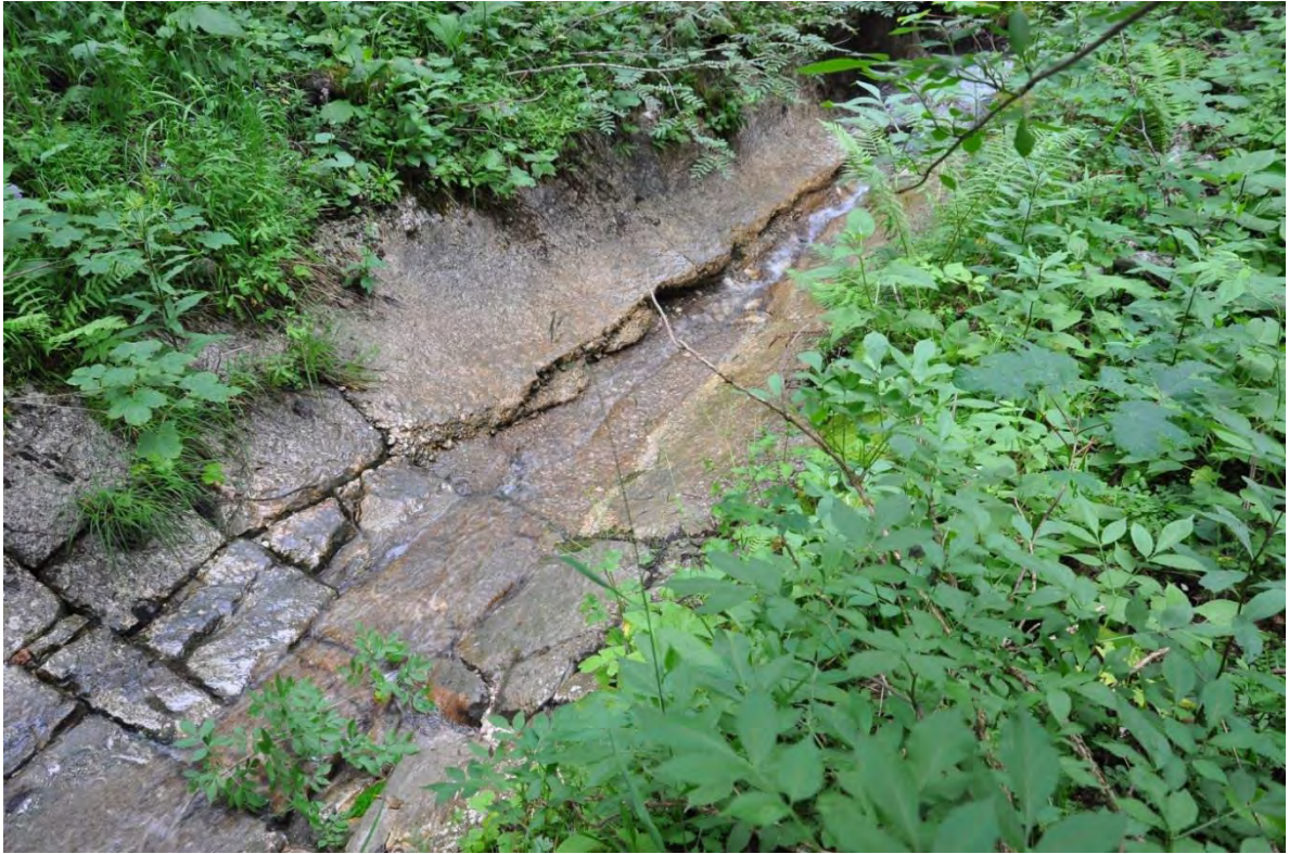
Abbildung 54, Beton versus Quadermauerwerk, Steinbergbachverbauung, Salzberghochtal, 1056m N47°33,898' E13°37,768'
