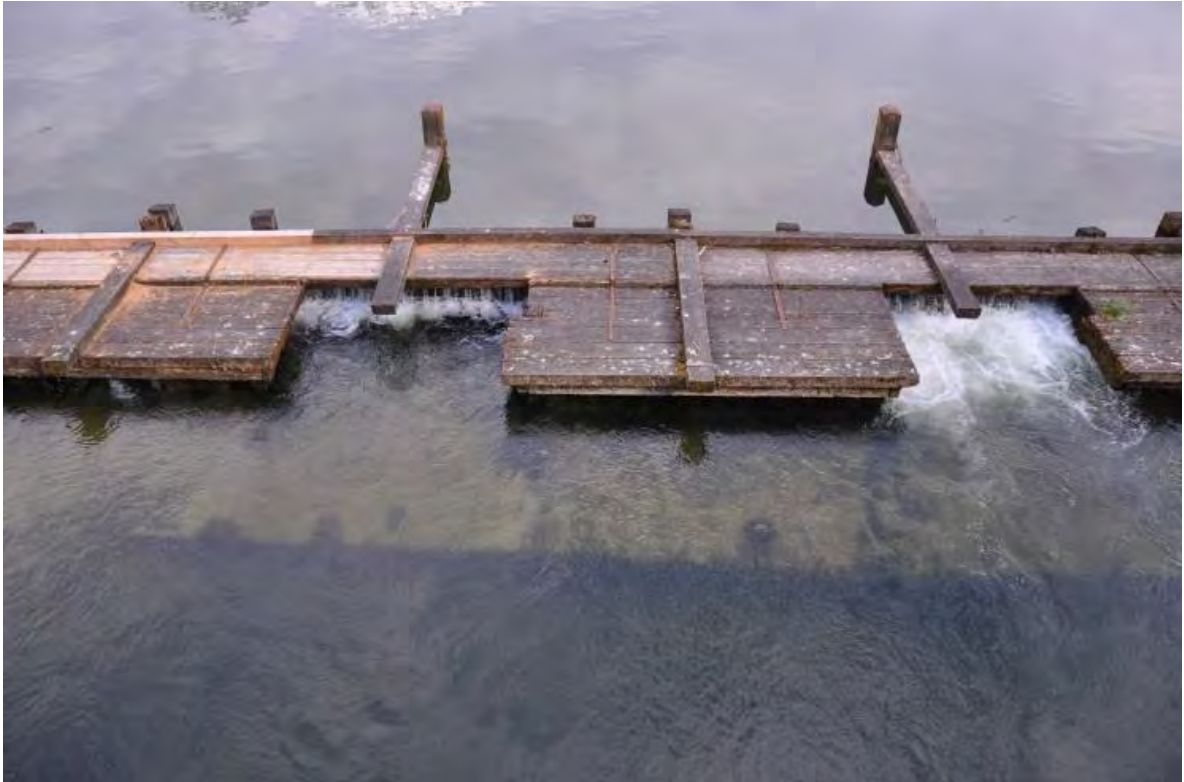
Abbildung 17, Pimmet (unter der Wasseroberfläche) vor den Klaustoren der Seeklause in Steeg - Foto Idam 2014.
