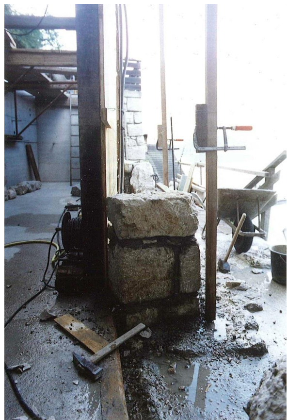
Abbildung 28, Latten - Schnurgerüst, im Vordergrund ein Meißelhammer. – Foto Idam.
