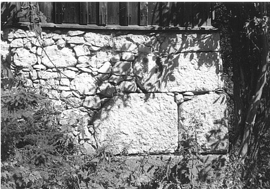
Abbildung 6, Schafferstadel Salzburg, Quader- und Bruchsteinmauerwerk, 18. Jahrhundert. Auszwickungen zwischen den Eckquadern.– Foto Idam.
