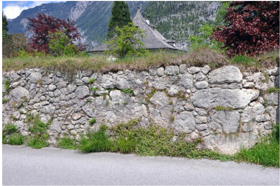
Abbildung 37, Mauerkrone aus Rasensoden, Hallstatt. – Foto Idam.
