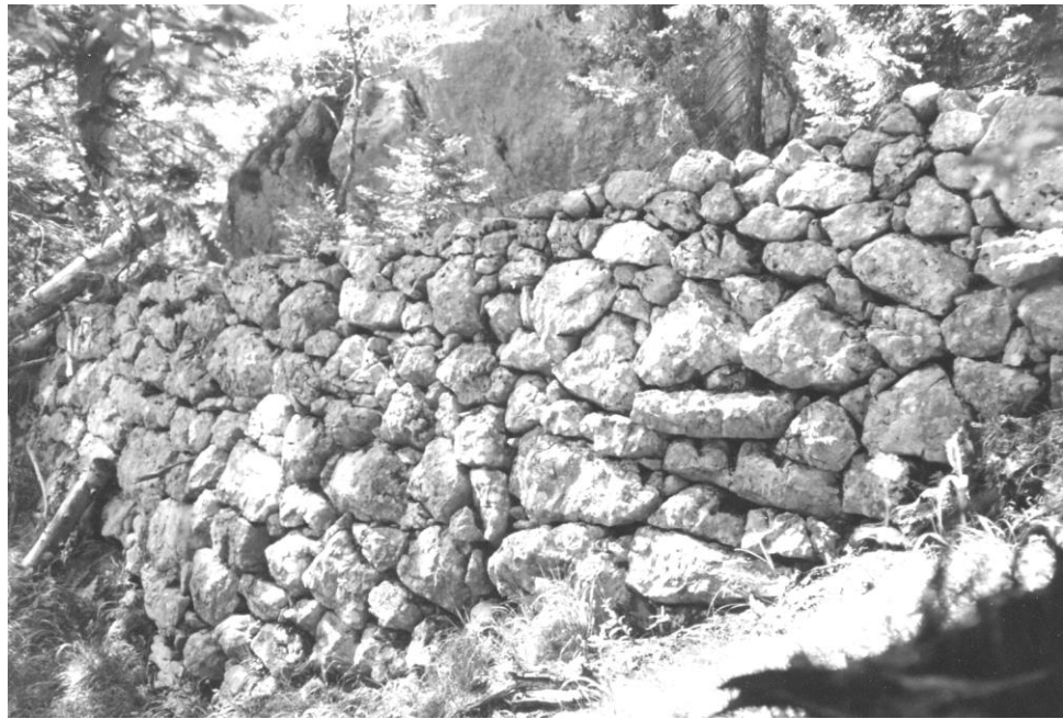
Abbildung 24, Zugweg Kreuzberg Ostflanke, Trockenmauerwerk, 19. Jahrhundert. – Foto Idam.
