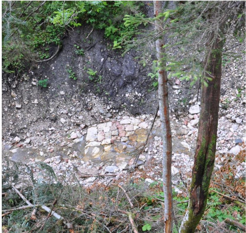
Abbildung 46: Steinbergbachverbauung, Erhaltenes Sturzbett aus Quadermauerwerk, 1056m N47°33,898' E13°37,768', Aufnahme Idam 2014
