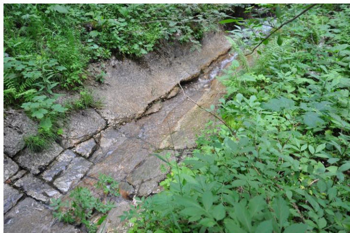
Abbildung 39, Beton versus Quadermauerwerk, Steinbergbachverbauung, Salzberghochtal Hallstatt., 1056m N47°33,898' E13°37,768 – Foto Idam.
