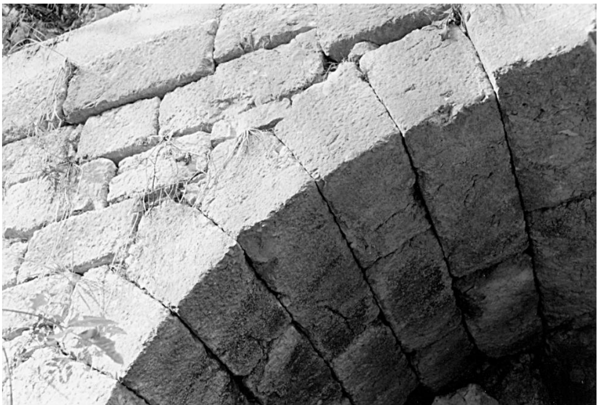
Abbildung 1, Bogenbrücke Soleleitungsweg km 1.6, Quadermauerwerk.
