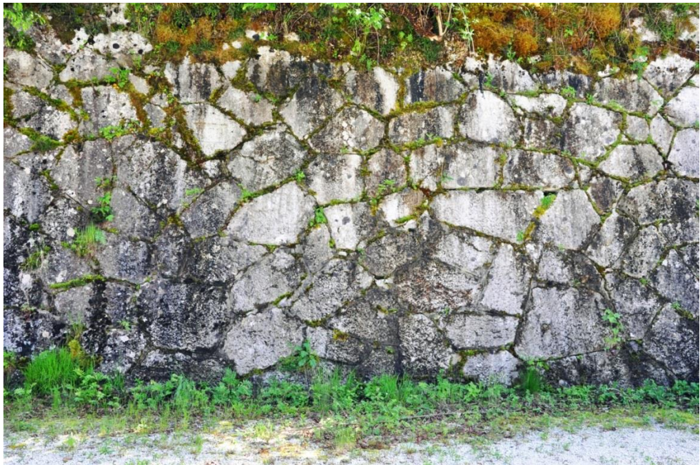
Abbildung 26, Salinarische Hackelmauer (Zyklopenmauerwerk) Hallstatt. – Foto Idam.
