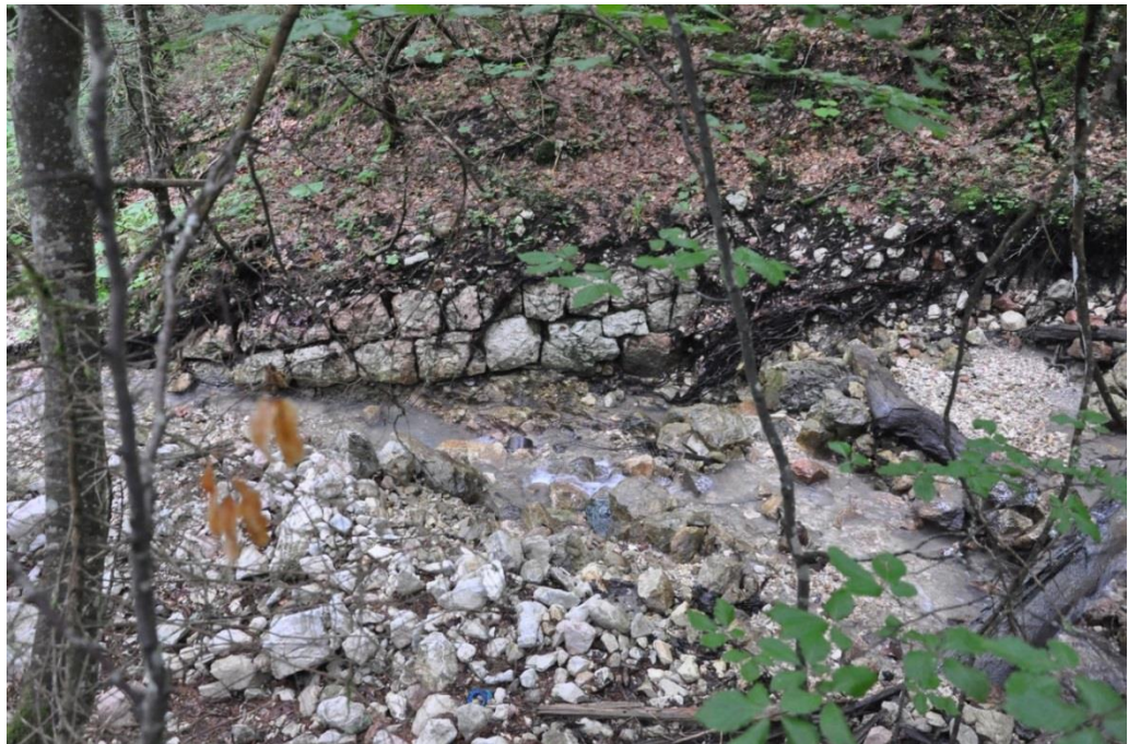
Abbildung 47: Steinbergbachverbauung, Rest einer Längsverbauung, Quadermauerwerk, 1078m N47°33,925' E13°37,717', Aufnahme Idam 2014
