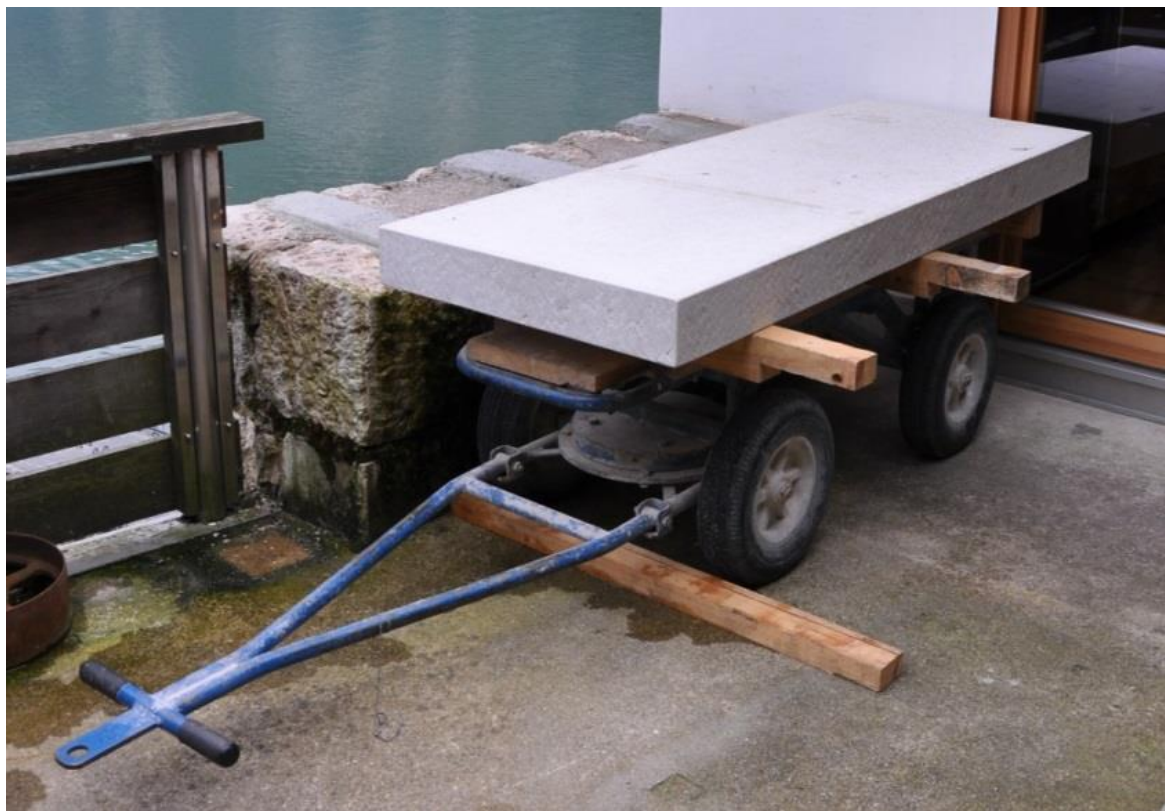
Abbildung 20, Transport einer Brüstungsplatte mit einem Steinkarren - Foto Idam
