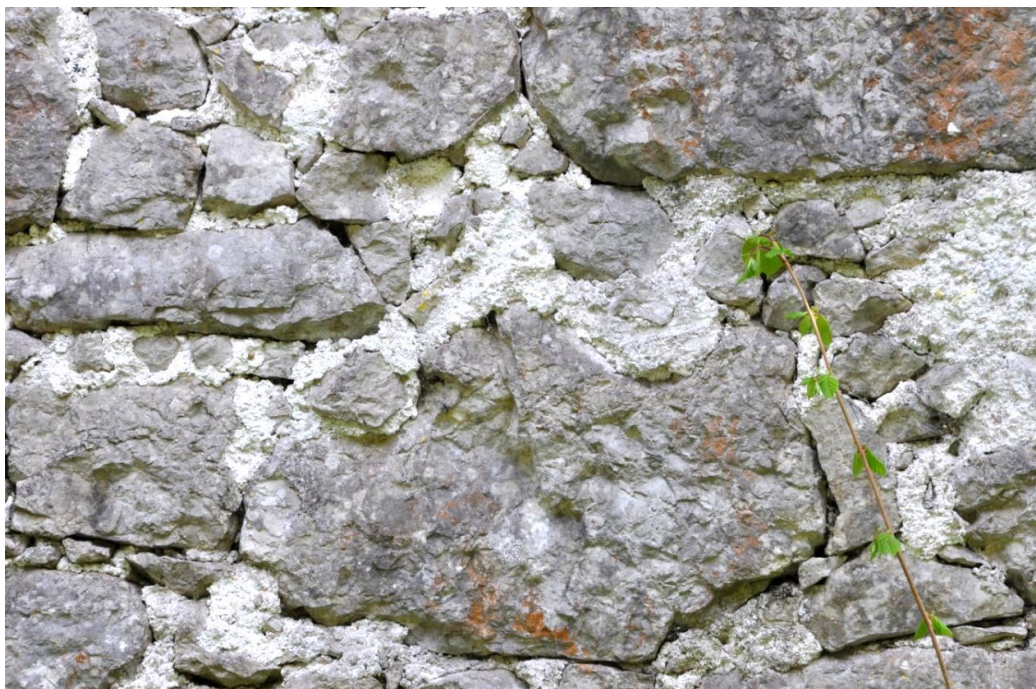
Abbildung 34, Kalkmörtelfuge um 1900, durch Dachvorsprung geschützt - Foto Idam 2014.
