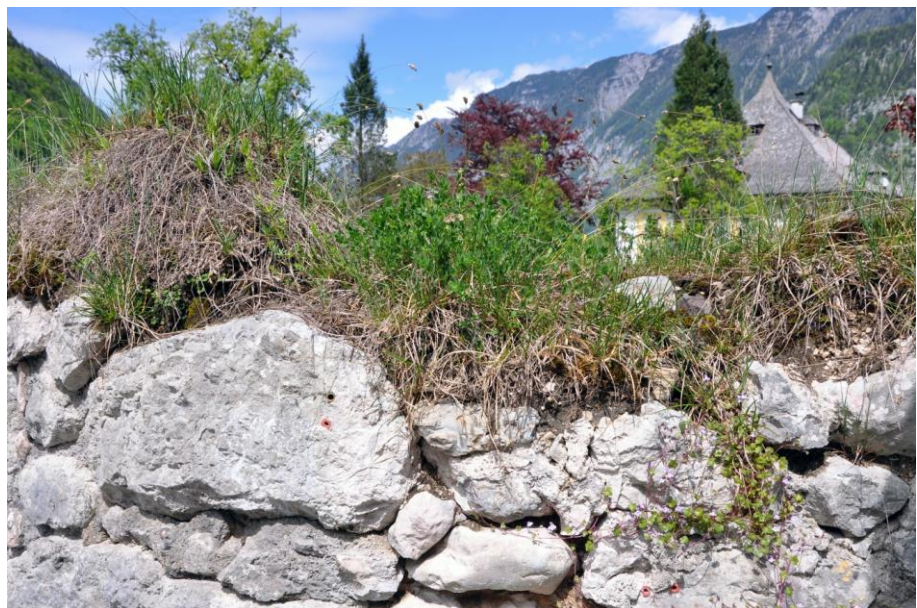
Abbildung 38, Mauerkrone aus Rasensoden, Detail, Hallstatt. – Foto Idam.
