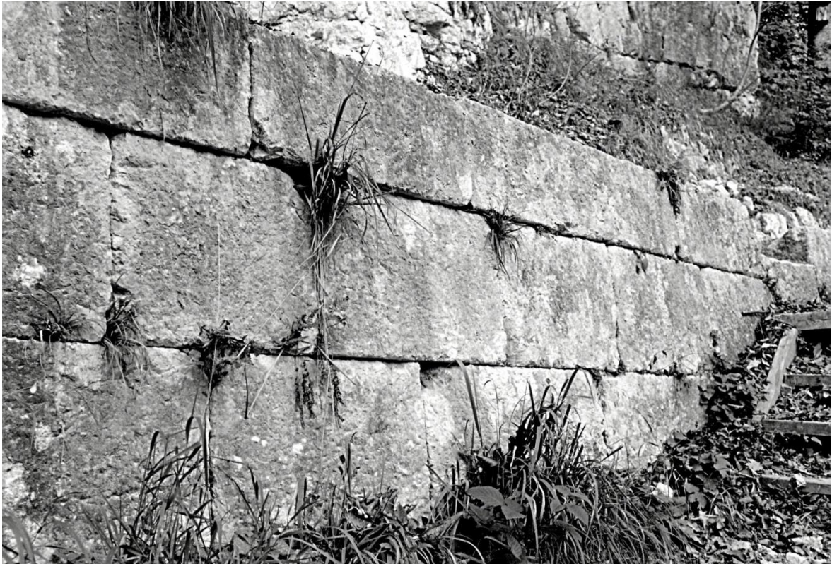
Abbildung 25, Salinarische Quadermauer, Soleleitungsweg Hallstatt. – Foto Idam.
