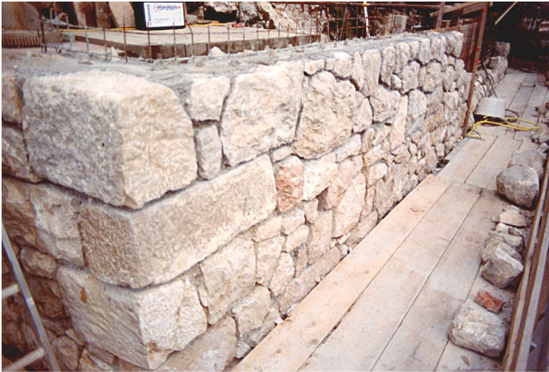
Abbildung 5, Haus Mortonweg 143, Stützmauer. Quader- und Bruchsteinmauerwerk, 1995 – Foto Idam..
