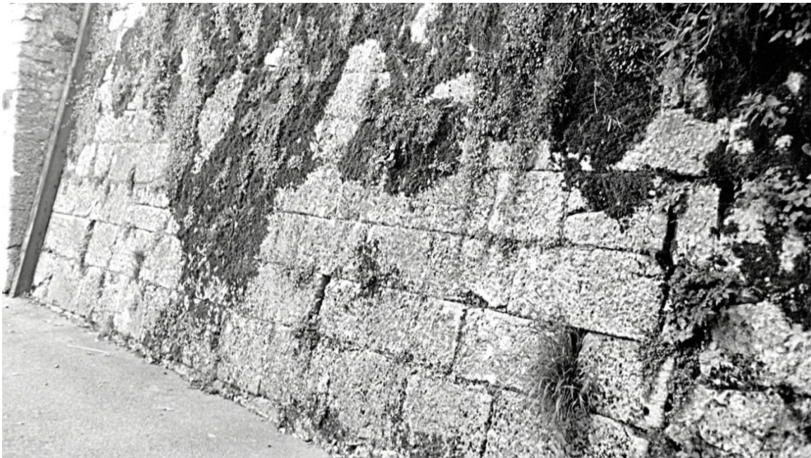
Abbildung 4, Stützmauer Hallstatt, Mortonweg - Foto Idam
