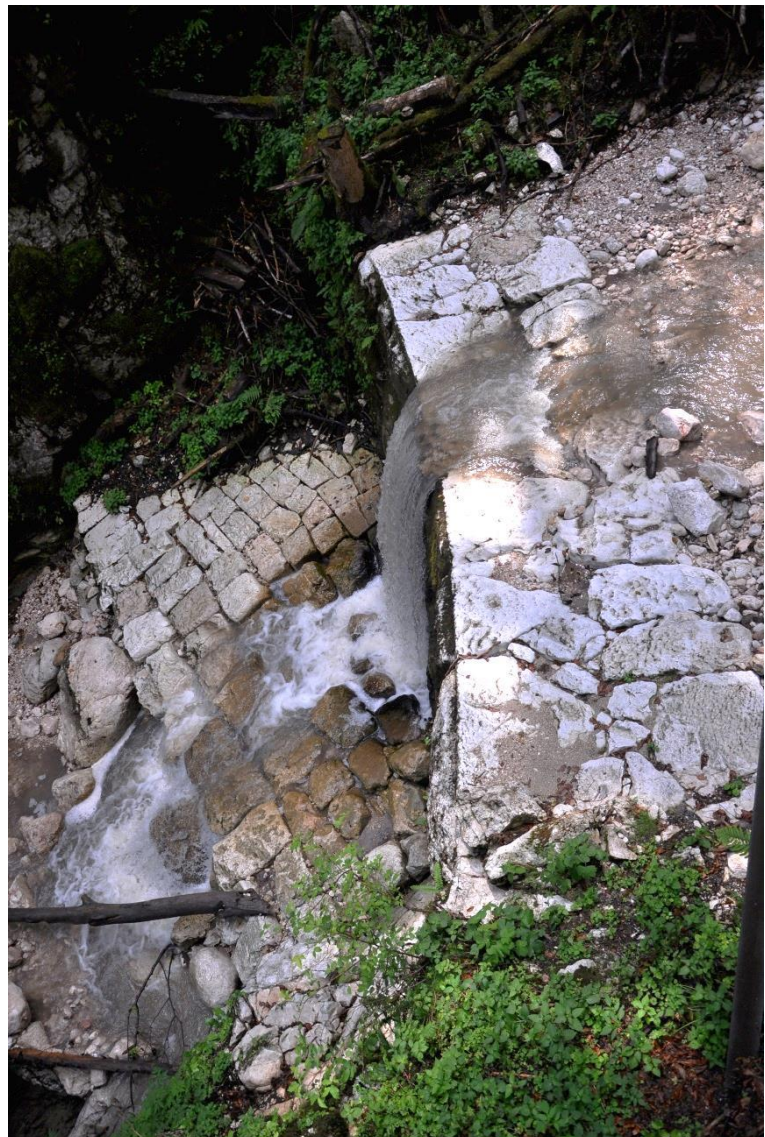
Abbildung 8, Verwendung von lokal anstehenden Steinmaterial, Hallstatt, Mühlbachverbauung Werk I 1884.– Foto Idam 2013.
