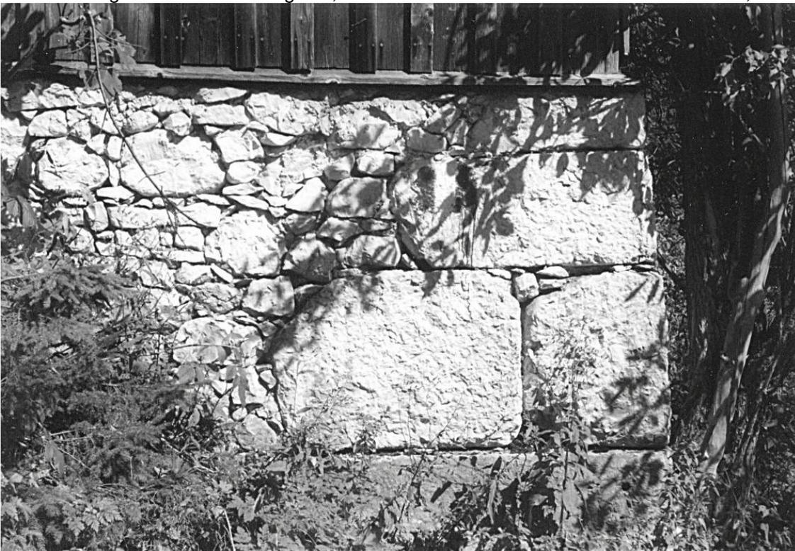
Abbildung 3 : Schafferstadel Salzburg, Quader- und Bruchsteinmauerwerk, 18. Jahrhundert.
