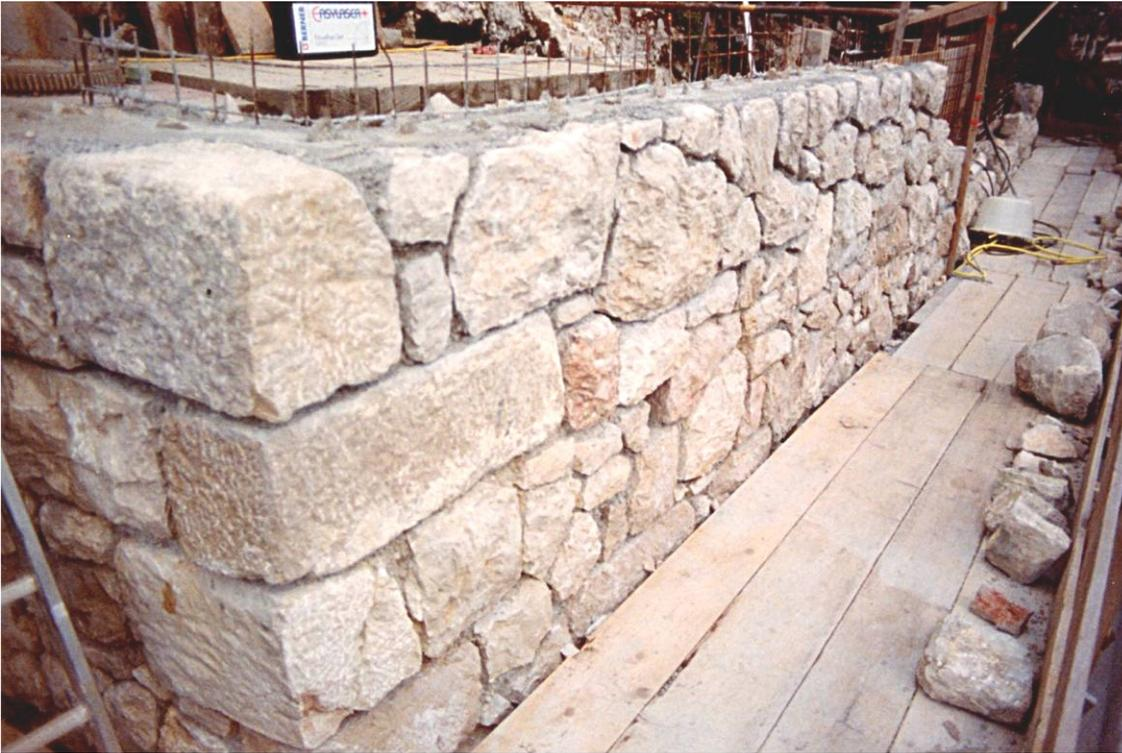
Abbildung 2 : Haus Mortonweg 143, Stützmauer. Quader- und Bruchsteinmauerwerk, 1995.
