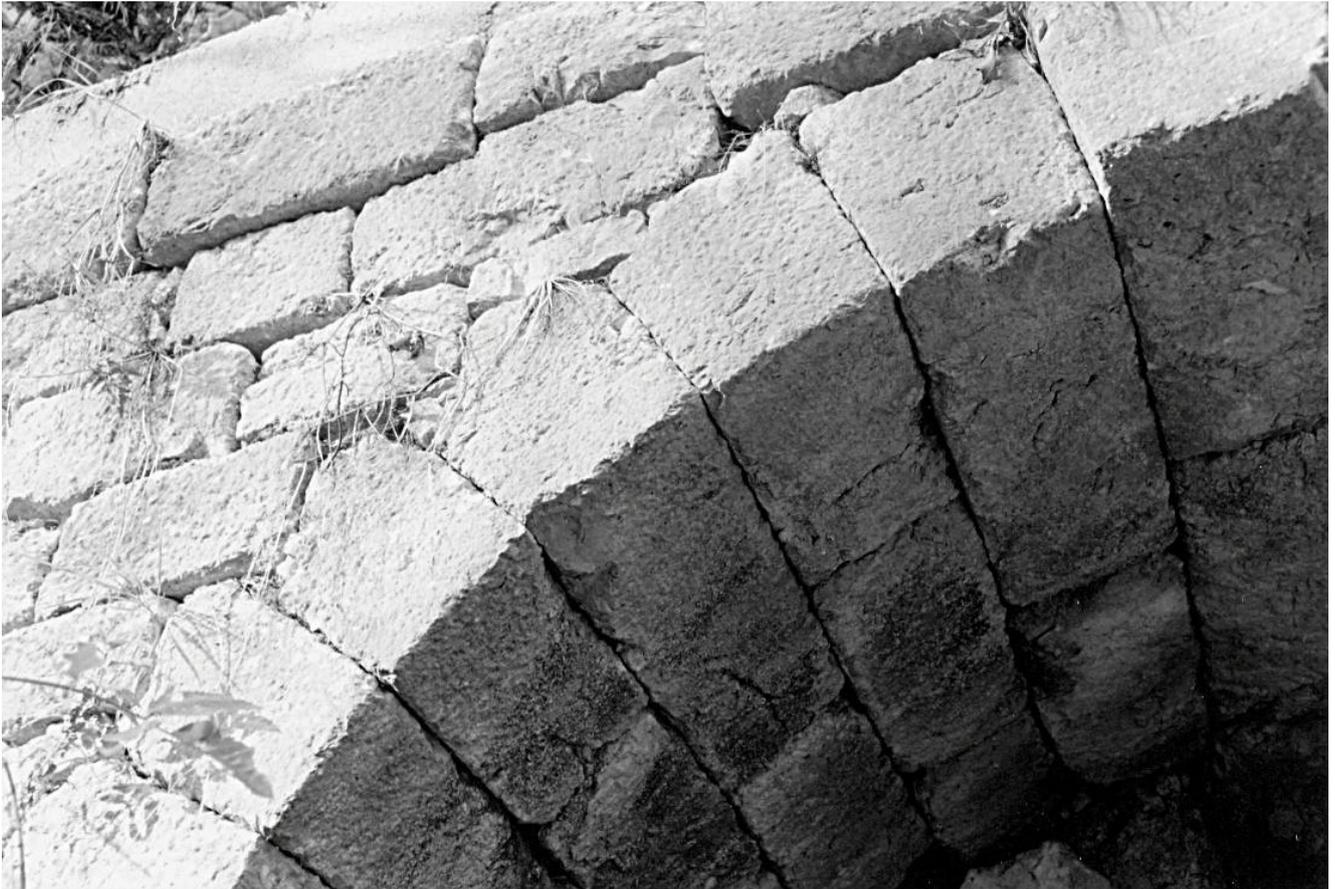
Abbildung 1 : Bogenbrücke Soleleitungsweg km 1.6, Quadermauerwerk.
