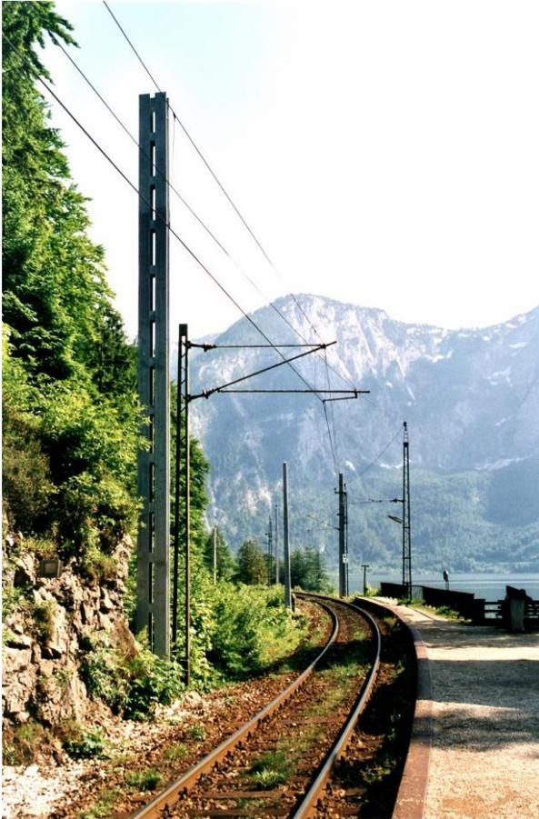
**Abbildung 1 Hallstatt (km 43) Juni 2000, neue Masten (HEB-Profil) neben alten Gittermasten kurz vor deren Demolierung.**
