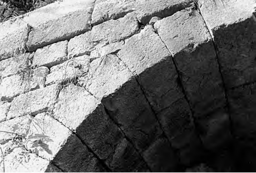
Abb. 1: Bogenbrücke Soleleitungsweg km 1.6, Quadermauerwerk (Foto: Idam 2001).
