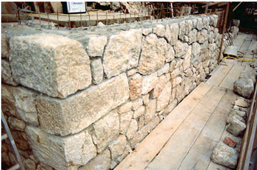
Abb. 5: Haus Mortonweg 143, Stützmauer. Quader- und Bruchsteinmauerwerk, 1995 (Foto: Idam).
