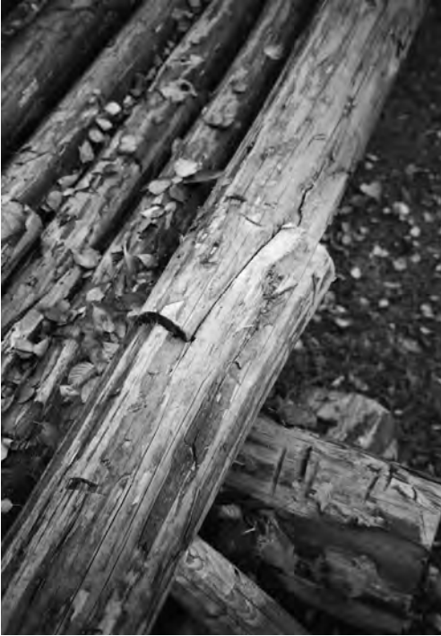
Abb. 49: Längsverbindung der Riesebäume (Foto: Kurt Druckenthauer 2007).
