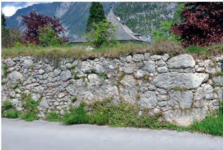
Abb. 37: Mauerkrone aus Rasensoden, Hallstatt (Foto: Idam).
