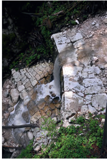
Abb. 8: Verwendung von lokal anstehendem Steinmaterial, Hallstatt, Mühlbachverbauung Werk I 1884 (Foto: Idam 2013).
