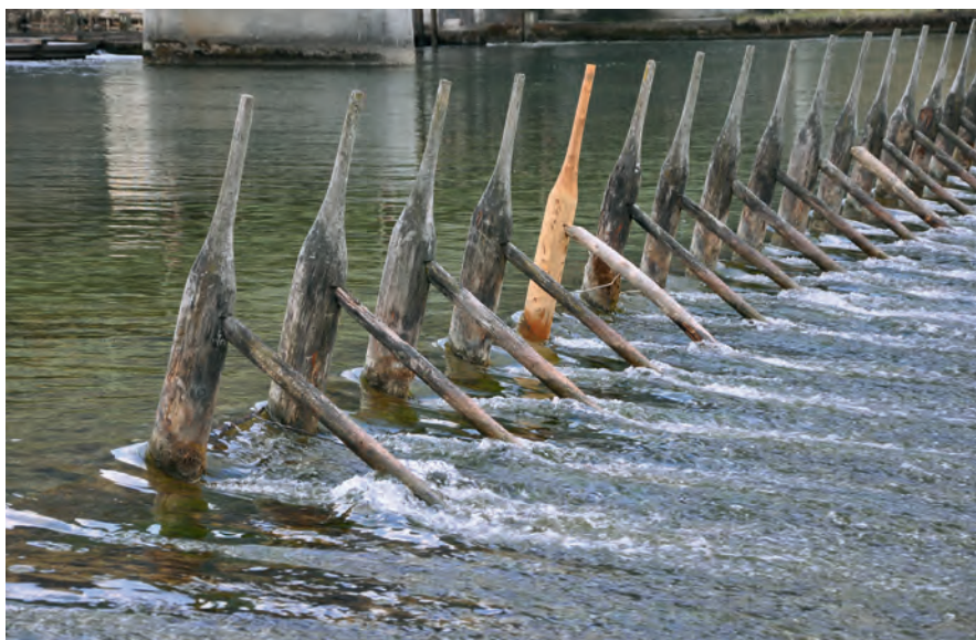
Abb. 51: Docken des Polsters der Seeklause in Steeg (Foto: Idam 2014).
