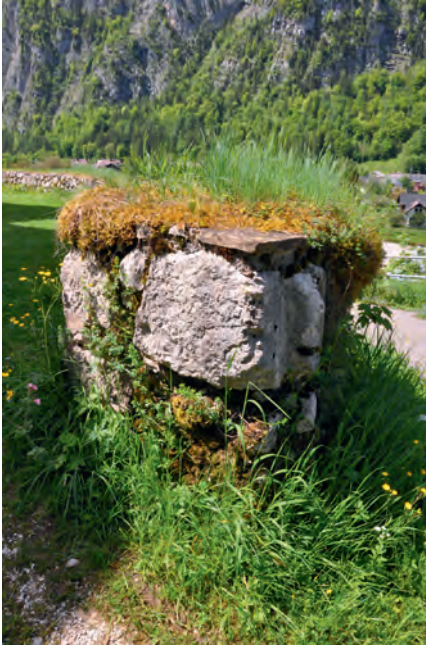
Abb. 7: Brüstungsmauer Hallstatt, Kalvarienberg (Foto: Idam 2014).
