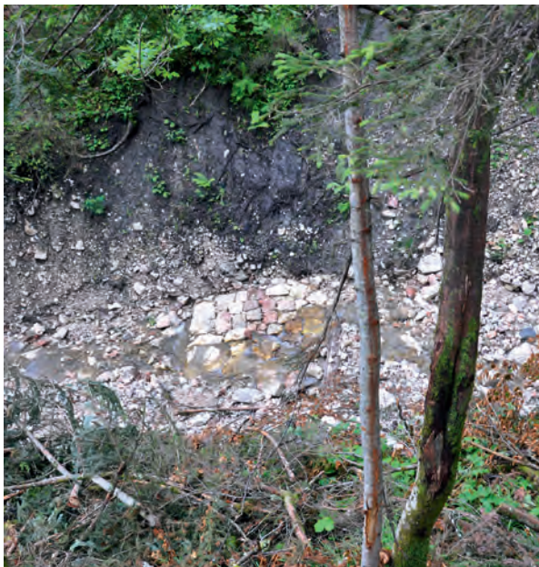
Abb. 76: Steinbergbachverbauung, Erhaltenes Sturzbett aus Quadermauerwerk, 1056m N47°33,898' E13°37,768' (Foto: Idam 2013).
