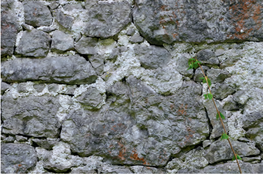
Abb. 34: Kalkmörtelfuge um 1900, durch Dachvorsprung geschützt (Foto: Idam 2014).
