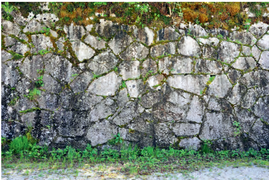
Abb. 26: Salinarische Hacklmauer (Zyklopenmauerwerk) Hallstatt (Foto: Idam).
