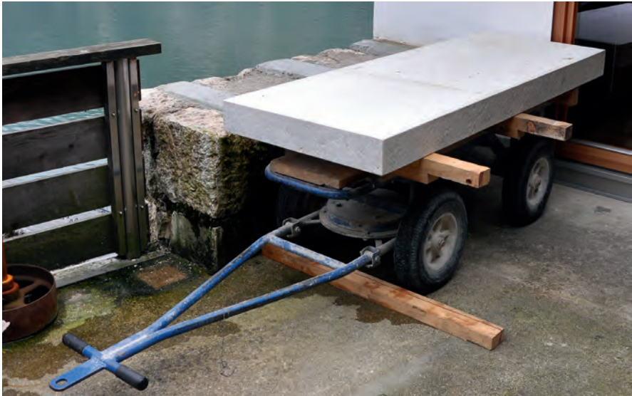
Abb. 20: Transport einer Brüstungsplatte mit einem Steinkarren (Foto: Idam).
