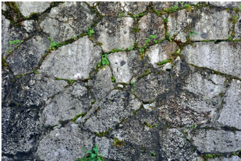
Abb. 27: Hacklmauer (Zyklopenmauerwerk), Detail, Hallstatt (Foto: Idam).
