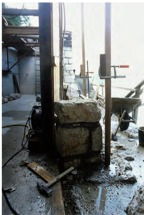
Abb. 28: Latten-Schnurgerüst, im Vordergrund ein Meißelhammer (Foto: Idam).
