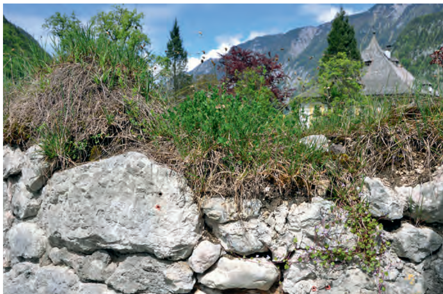
Abb. 38: Mauerkrone aus Rasensoden, Detail, Hallstatt (Foto: Idam).
