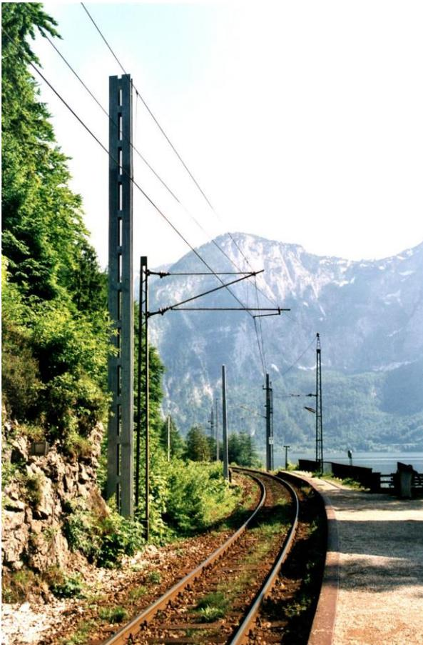
**Abbildung 7 Hallstatt (km 43) Juni 2000, neue Masten (HEB-Profil) neben alten Gittermasten kurz vor deren Demolierung.**
