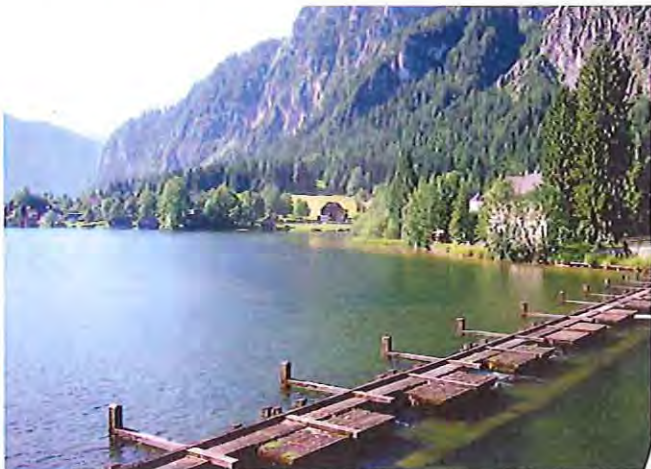
Abb. 50: Die "Klausstuben" (mit Steinen gefüllte Kästen, zwischen denen sich drehbare Tore befinden) bei Steeg (Gem. Bad Goisern), wo am Nordende des Hallstätter Sees der Abfluss in die Traun reguliert werden kann.
